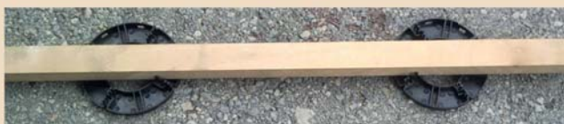
ukázková aplikace terasových hranolů na terčích
