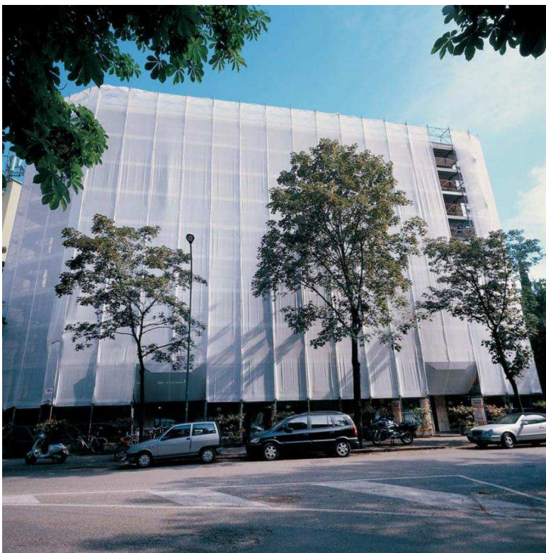
ukázka použití na staveništi
